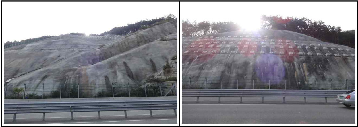
【그림 25.3.4】 보호/보강시설 전경
