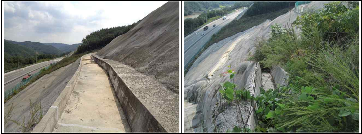
【그림 25.3.3】 배수시설 전경
